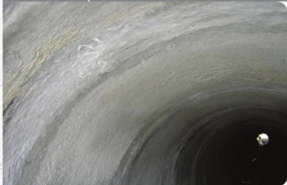
По окончании работ
