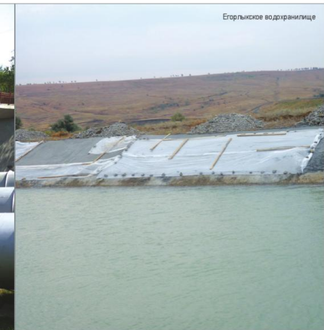
Водоприемная шахта Егорлыкской ГЭС
