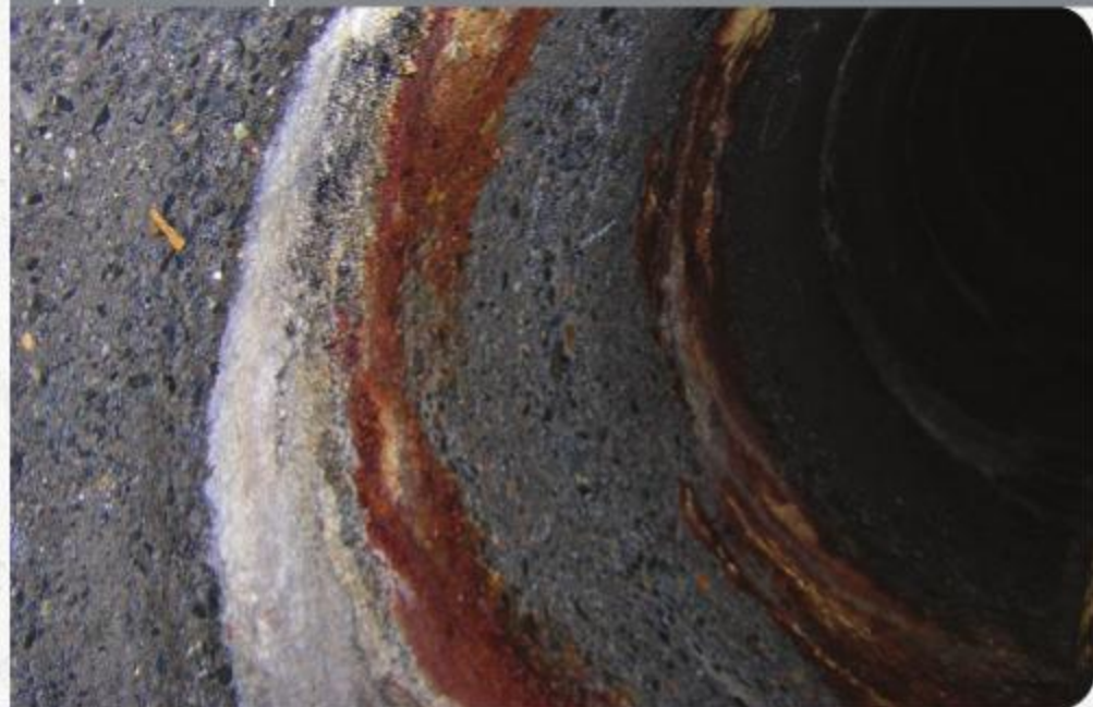
До начала работ
